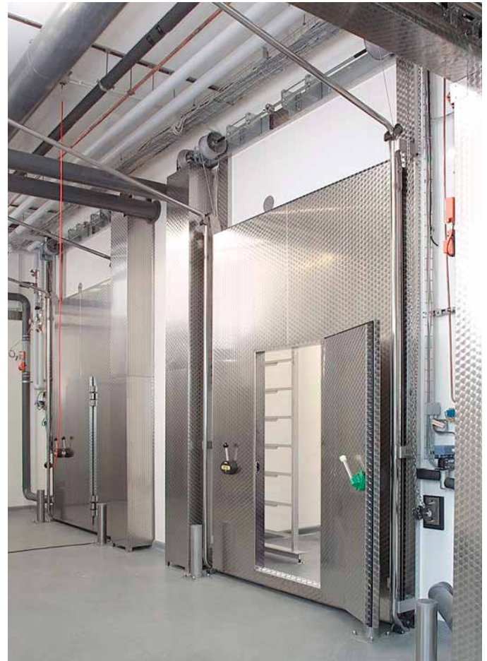
Hubtore im V2A passgenau geplant und eingebaut.
