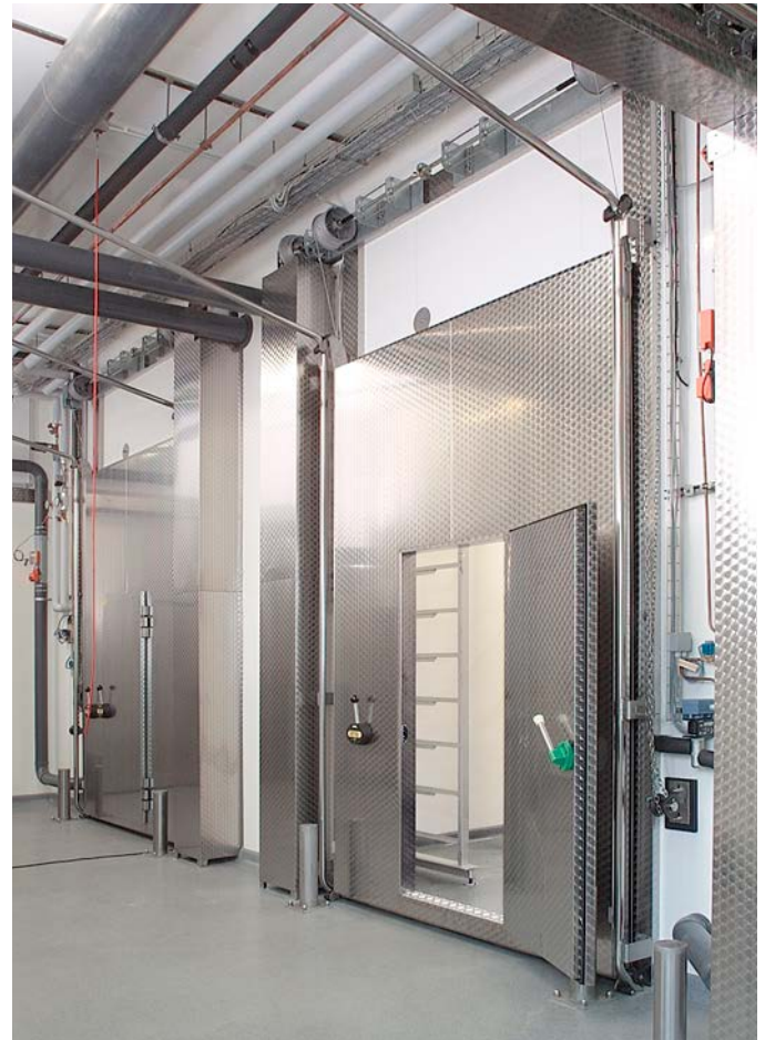
Hubtore im V2A passgenau geplant und eingebaut.
